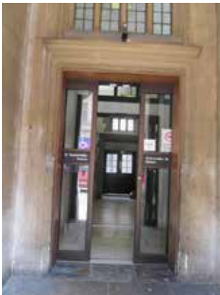
automatic doors entrance.jpg
