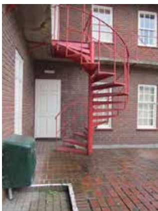
spiral staircase exit.jpg
