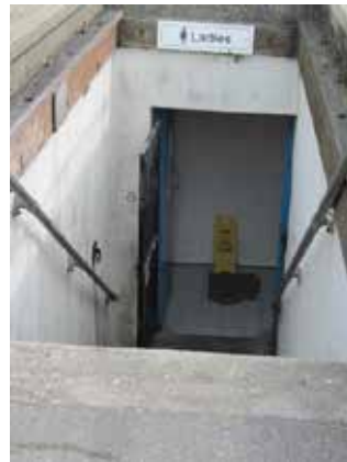
ladies toilets underground.jpg
